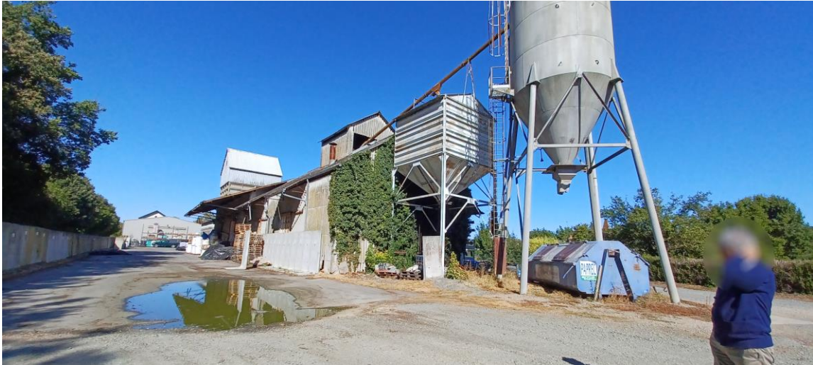
Vues sur le silo
